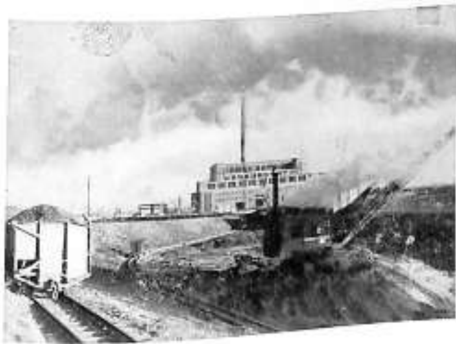
Kraftwerk Lohde im Wiederaufbau.
