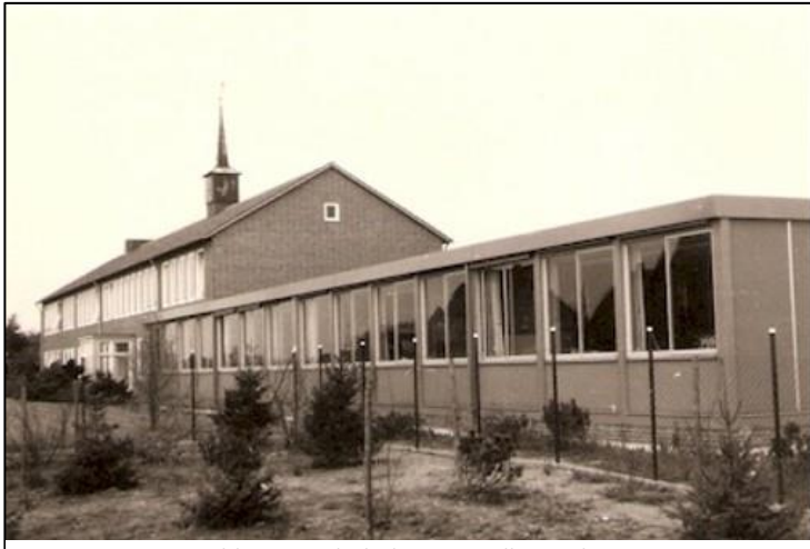
Bild 4: Grundschule mit Pavillon-Anbau
