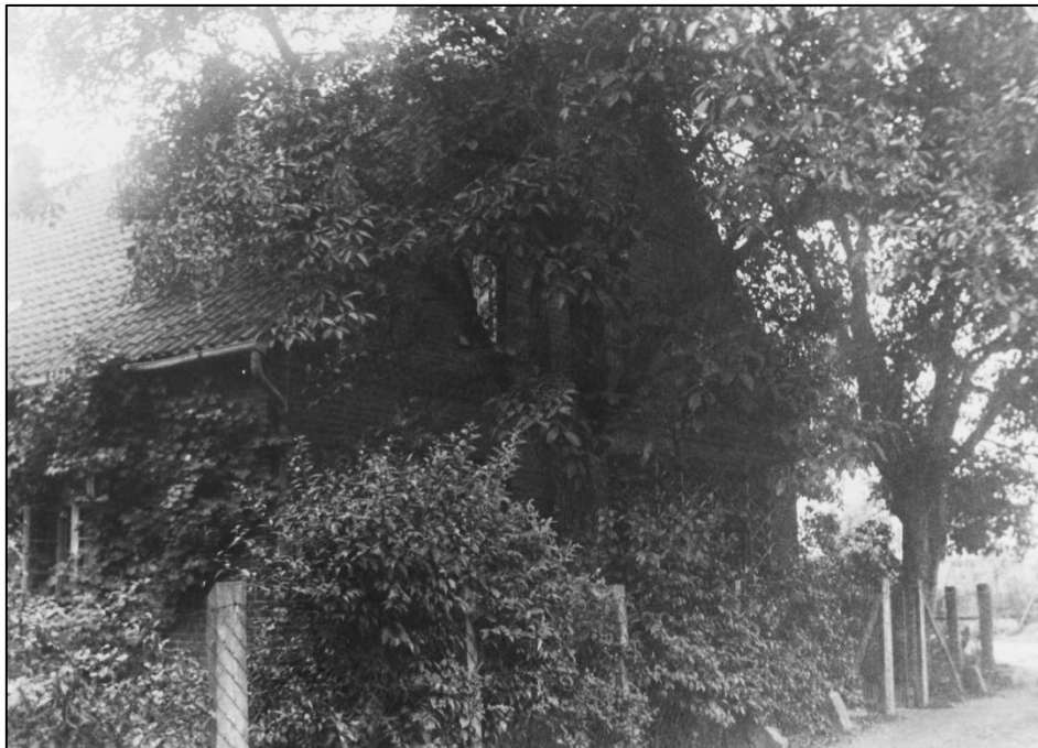
Bild 3: Blick von der Nienburger Straße auf das alte Amtshaus
