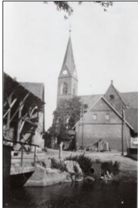
Bild 3: Lahder Klostermühle mit Blendwerk zur Straße hin
